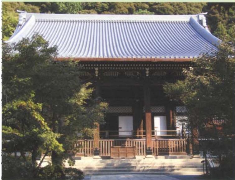
屋根が葺き替えられた御影堂
